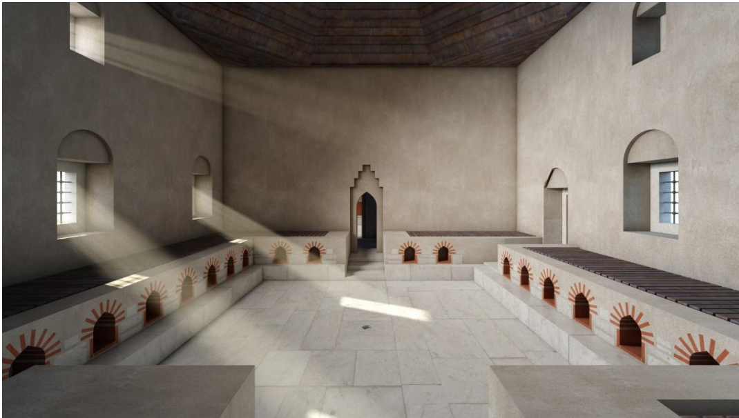
Εικόνα 30: Λίθος, πλίνθοι και ξύλο για την ανακατασκευή των καθισμάτων και σιδεριές στα παράθυρα
