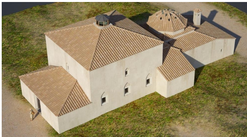
Εικόνα 28: Τρούλος και οπές για την εξασφάλιση του φωτισμού
